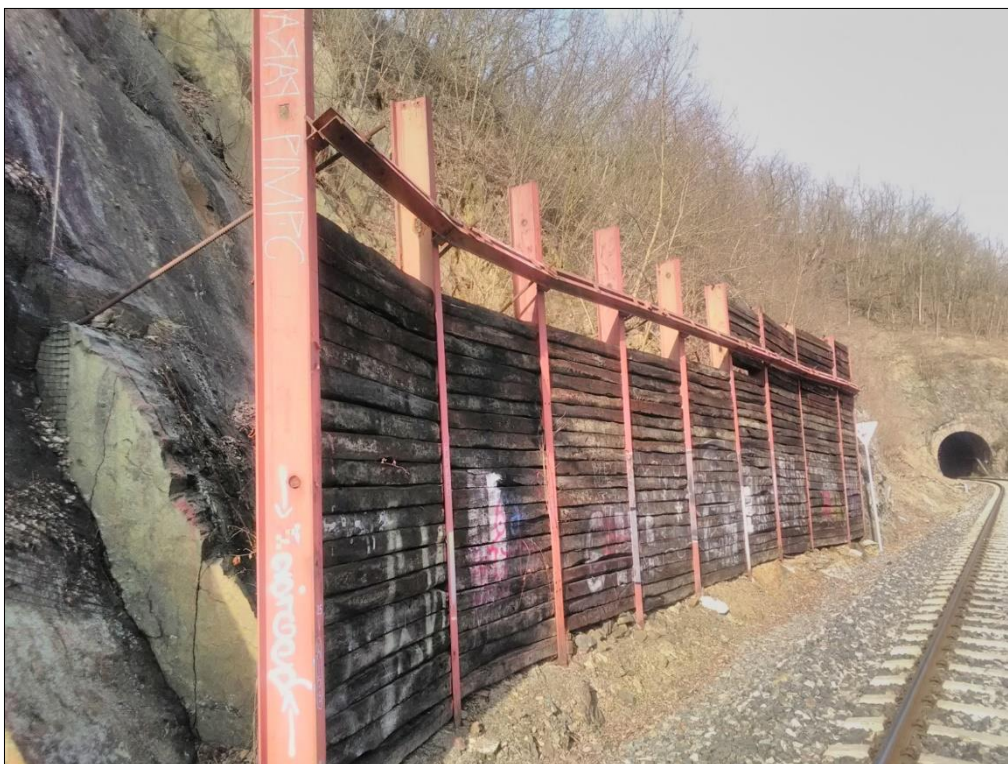
Obr. 17: Zajištění svahu nepříznivě ukloněných lavic metamorfovaných drobových břidlic záporovým pažením s kotvením.
