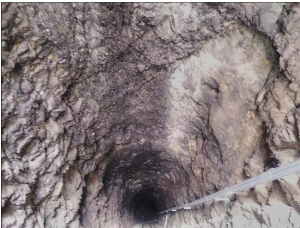
Obr. 16: Jílovský tunel – vystrojené jsou pouze příportálové úseky délky cca 10 m. Přes tuto skutečnost je nutné konstatovat, že masiv drobových břidlic je velmi rozpukaný. Patrné jsou tektonické zóny – viz schématický zakreslení linií, v daném místě – přibližně 30 m od portálu Luka pod Medníkem byly patrné úkapy z klenby, zřejmě dlouhodobé.
