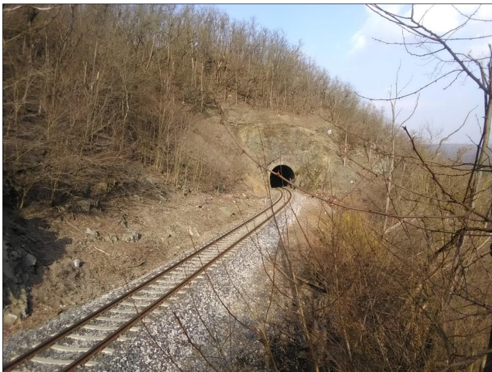
Obr. 14: Celkový pohled na Jílovský tunel II.
