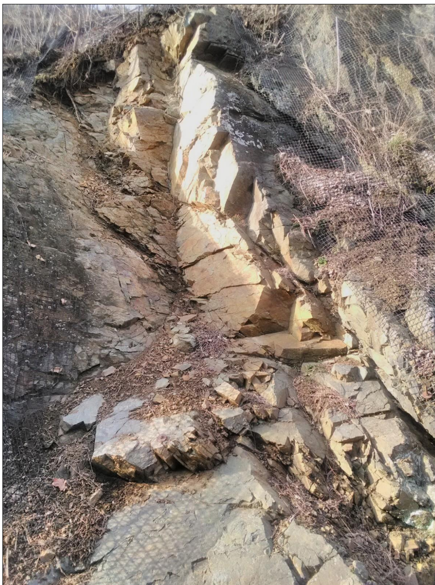
Obr. 18: Masiv nepříznivě ukloněných metamorfovaných nazelenalých břidlic u záporového pažení. Patrné jsou zbytky protierozní sítě. Masiv je pravděpodobně dotčen smykovým posunem.
